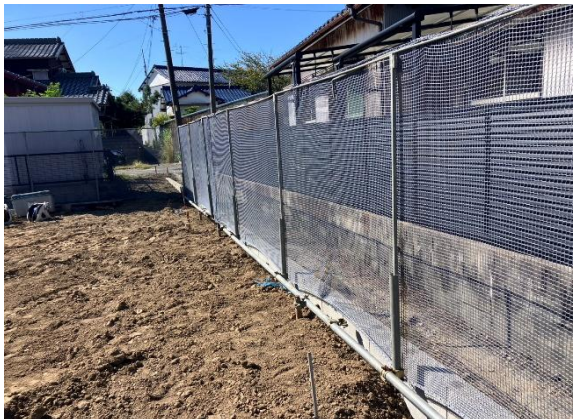
ネットフェンスきれいに施工されていました。
