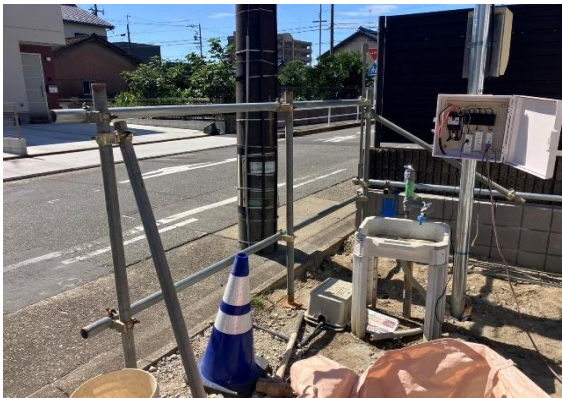
パネルフェンス骨組み部問題なし。
