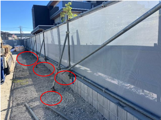
フェンス控え全てに補強材施工されていました 杭は効いていましたがポイントで太杭使用されてるともっと良かった。
