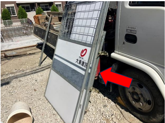
部材の立てかけあり。
