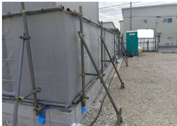
④ シートフェンス施工良好
