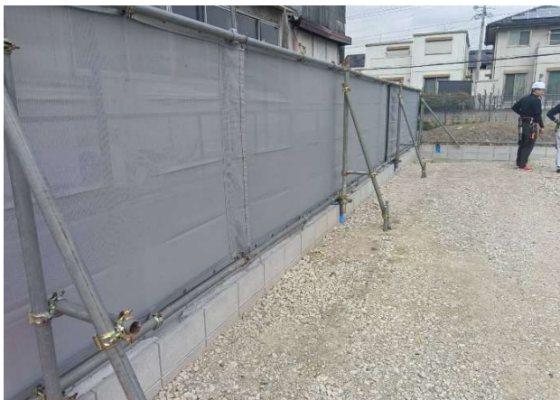
③ シートフェンス施工良好
