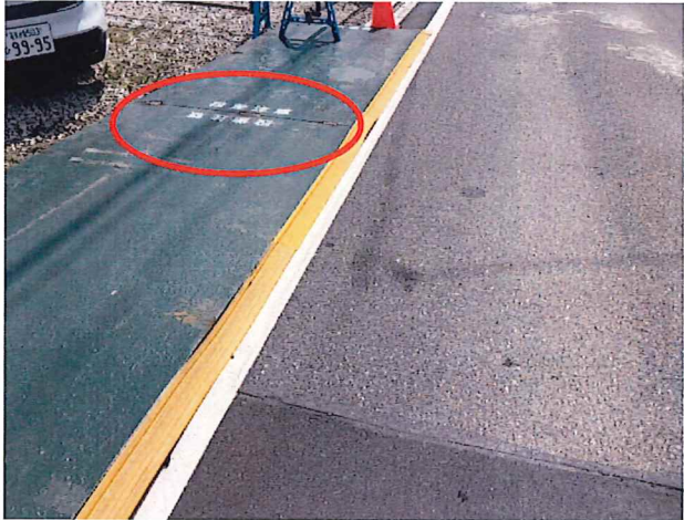
乗り入れ鉄板 溶接問題ありませんでした
