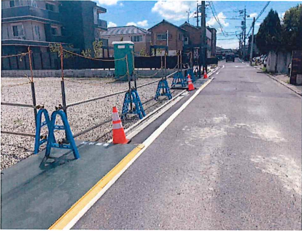
現場正面状況
