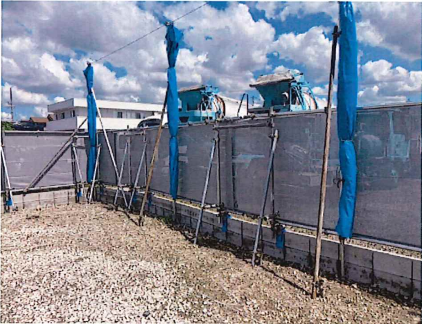
杭養生状況 問題ありませんでした
