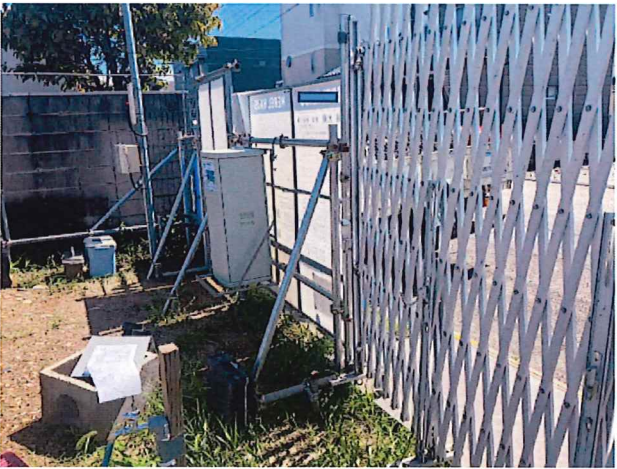
当社オリジナルフェンス骨組み状況 問題なく施工されていました
