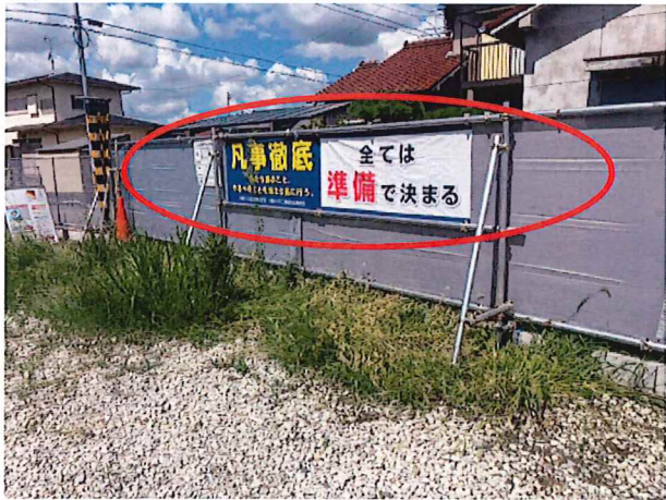
お客様の掲示物状況 骨組み施工できれいでした
