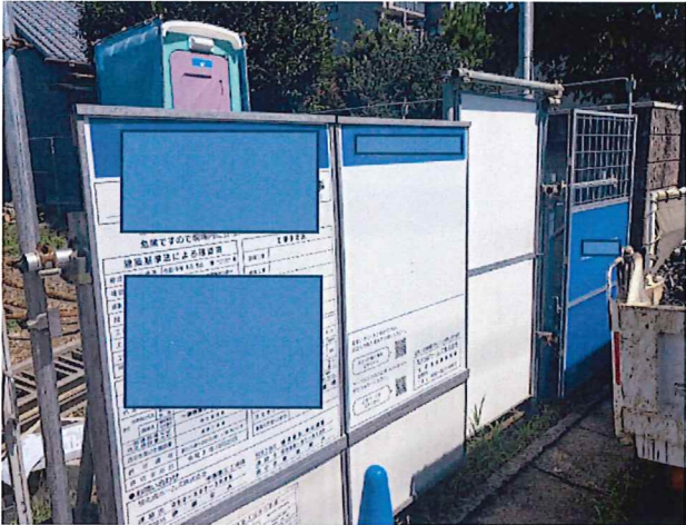
現場正面フェンス状況
