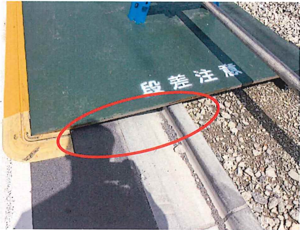
鉄板側面のL字溝部、段差状況 お客様と打ち合わせ必要
