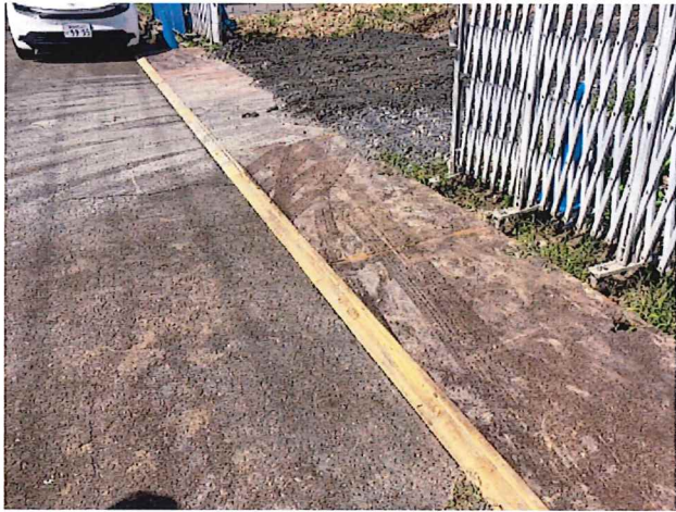
乗り入れ鉄板状況 溶接共にしっかり施工されていました
