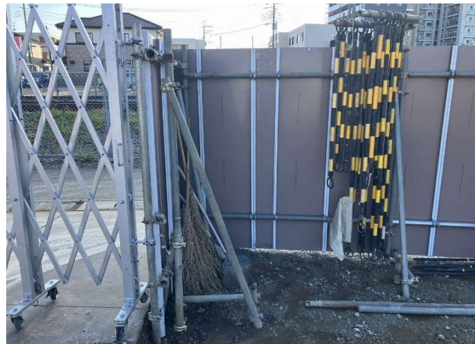
コーナー部施工・ゲ-ト取付 OK
