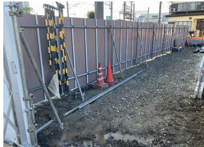
施工状況 ゲ-ト 煽り止めパイプ 搬入OK
