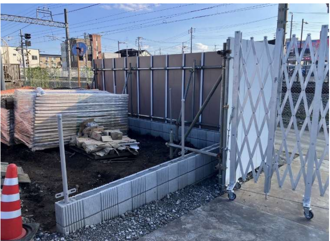
コーナー部施工・ゲ-ト取付 OK
