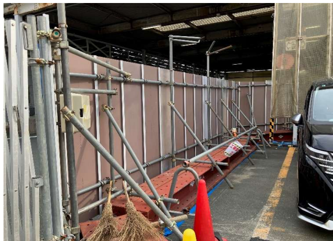
仮囲い骨組みOK
