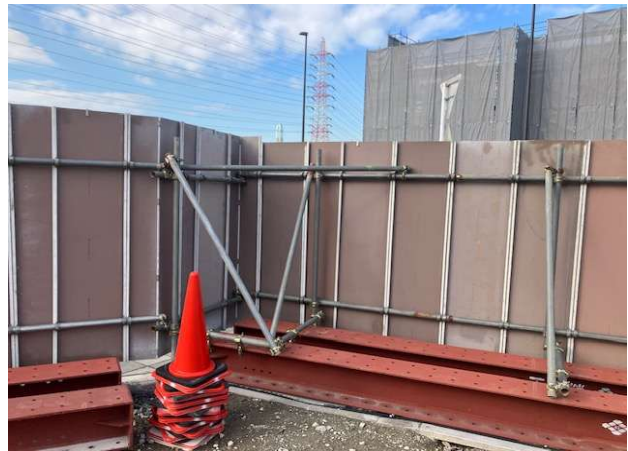
② 火打ちの設置
