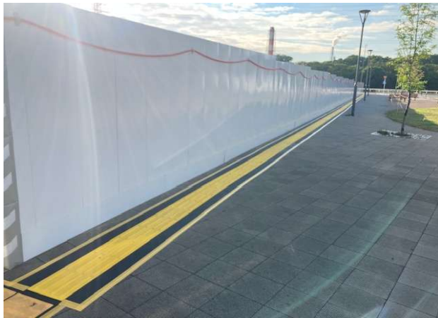
① 万能板設置状況
