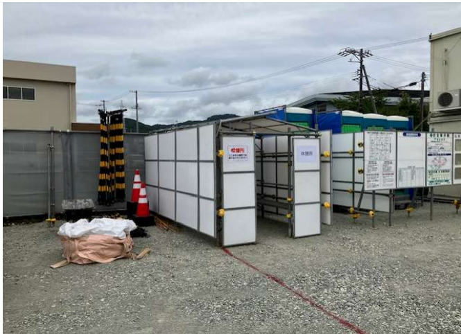
安全掲示板&休憩所OK
