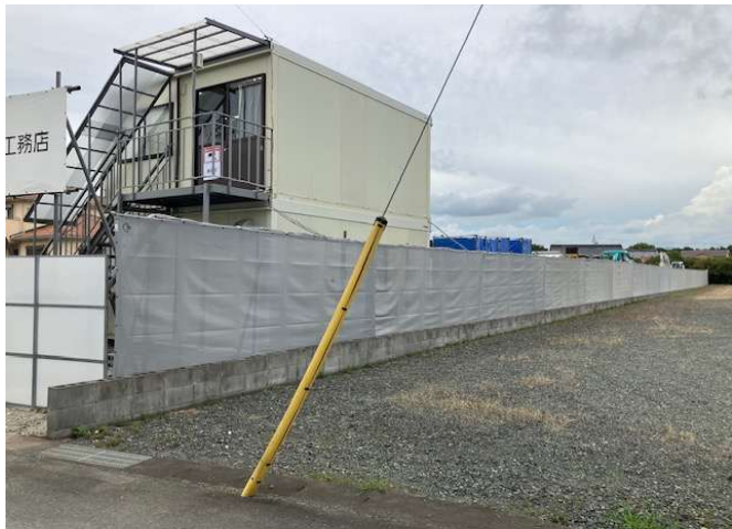
単管シートフェンスOK
