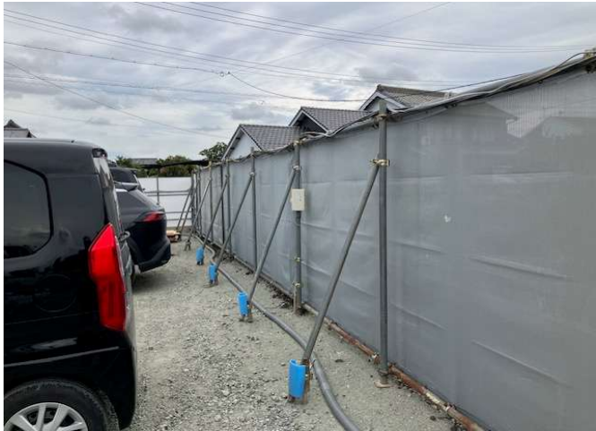
仮囲い骨組みOK
