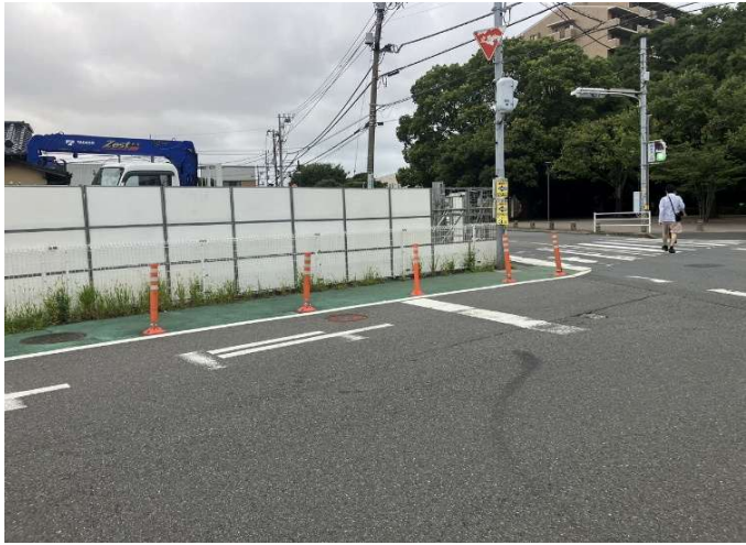
外観 施工 OK
