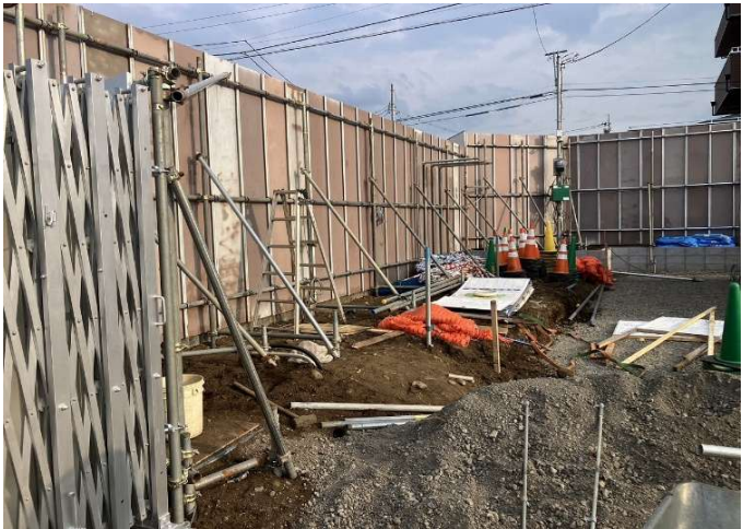
施工部 補強OK
