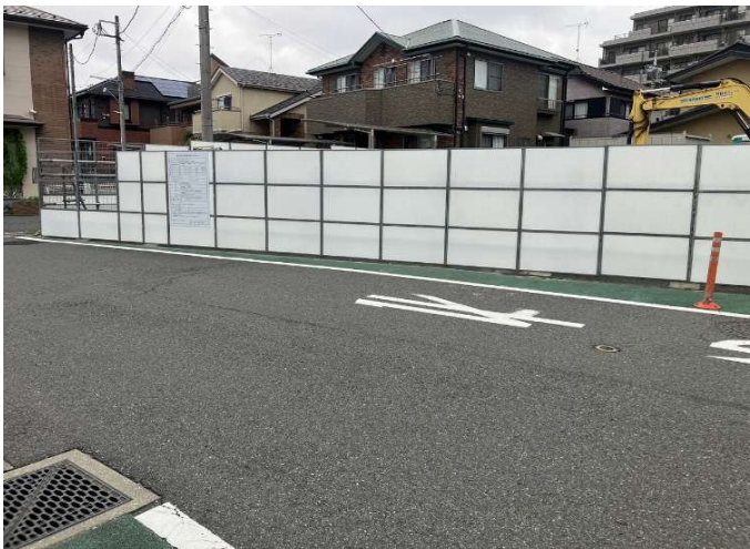
外観 施工 OK
