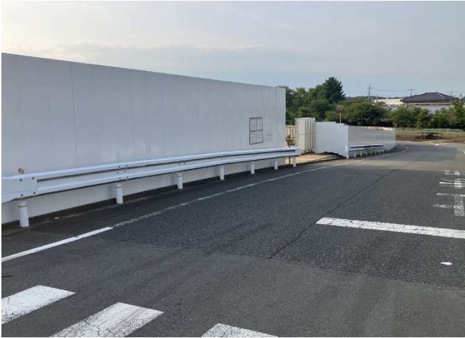
外観 通りゲ-ト施工など OK
