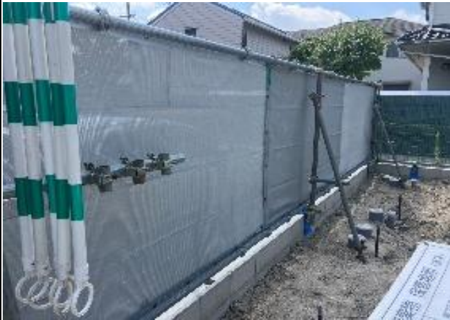
シートフェンス状況
