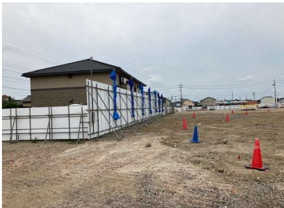
③ 杭養生、3Hフラット骨組み良好
