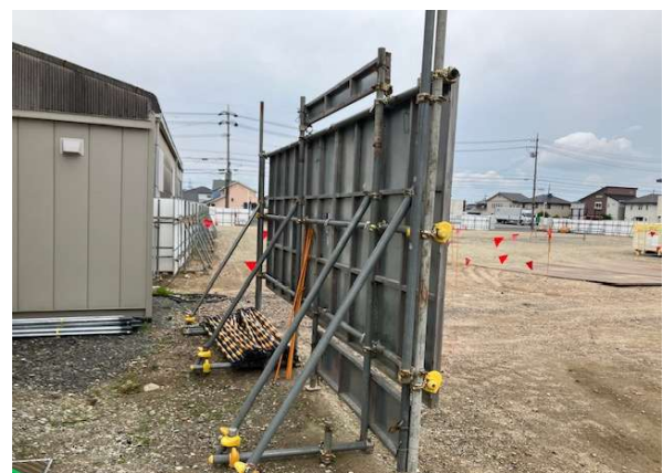
④ 朝礼看板骨組み良好
