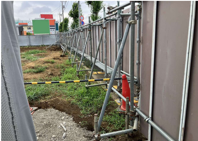
道路占用部 下地用足場材施工 OK
