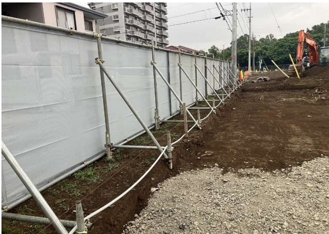
通り・打込強度など OK
