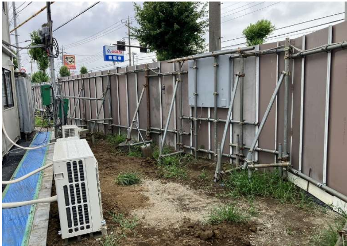
サ-ネ-ジ 施工部 補強OK
