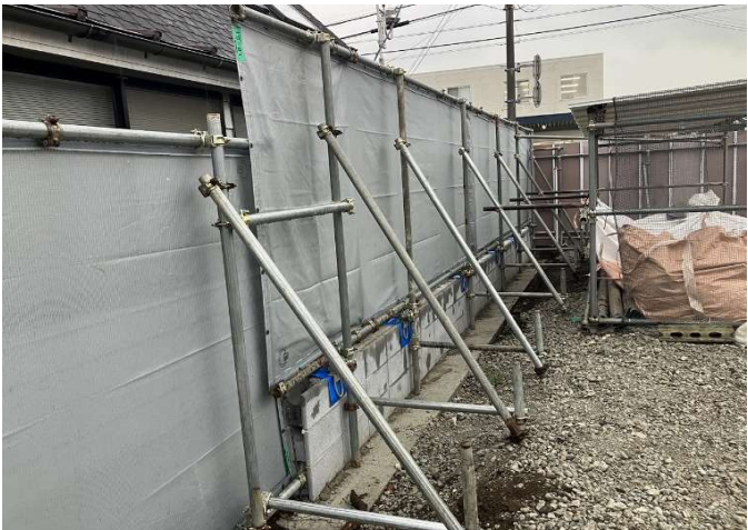
施工方法変更部 取り合い OK
