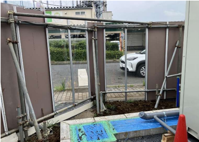
見通し対応 火打ち補強 OK
