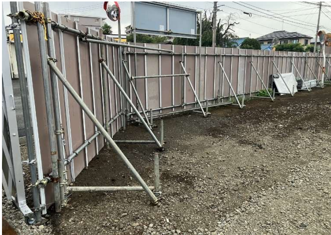
隅切りゲート施工 OK
