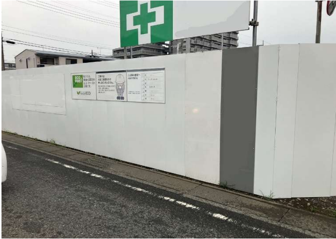
外観 通り 施工など OK
