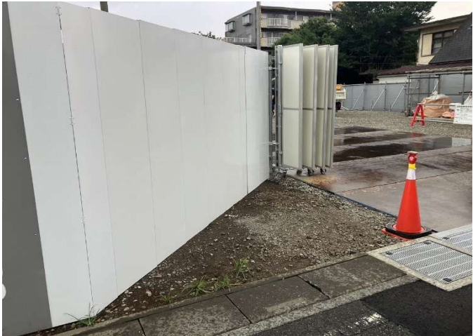
隅切りゲート施工 OK
