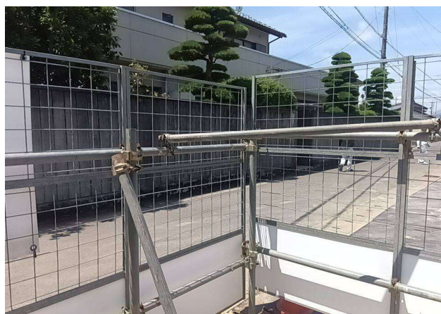
④ 火打ちは水平に取る様にする
