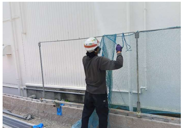
④ バリアネットフェンス施工中
