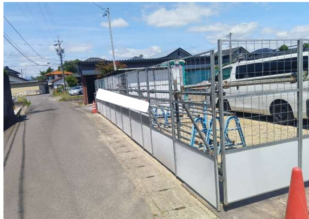
② パネルフェンス施工良好
