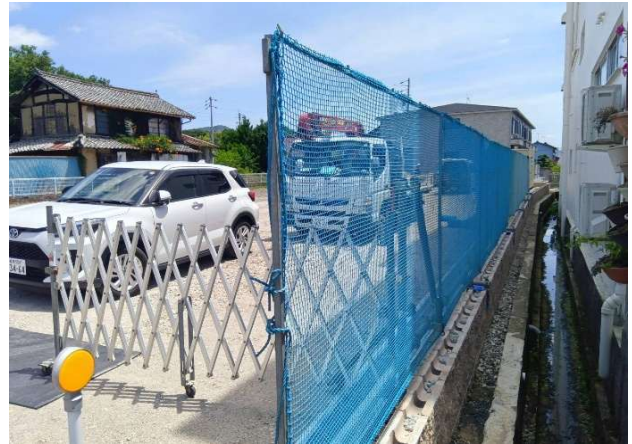
② バリアネットフェンス施工良好
