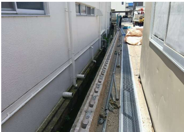
③ 部材の間配り良好
