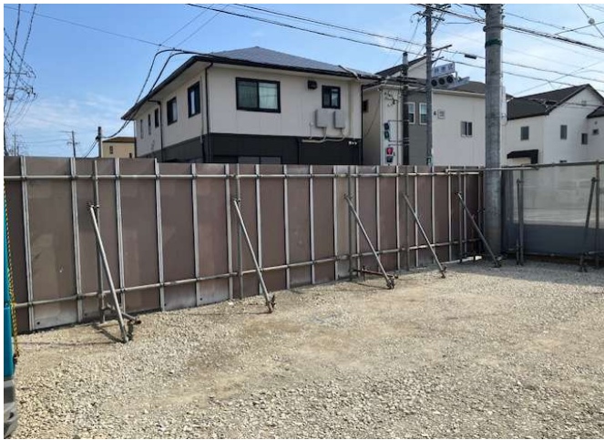
仮囲い骨組みOK
