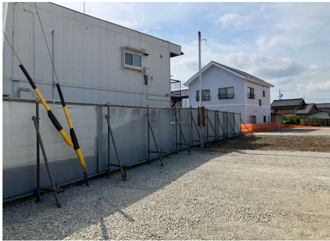
単管シートフェンスOK
