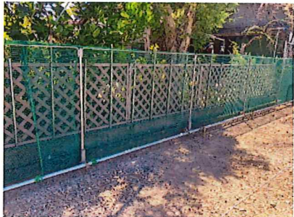
ネットフェンス状況
