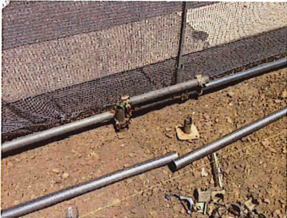
単管補強状況
