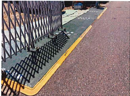
乗り入れ鉄板状況 綺麗に施工されていました
