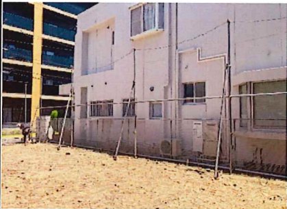
杭養生 施工途中 施工、作業状況問題なし
