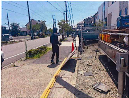
鉄板施工状況 問題ありませんでした
