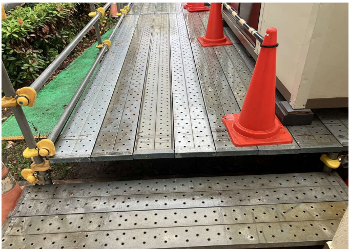
ユニットハウス設置後 通路 OK
