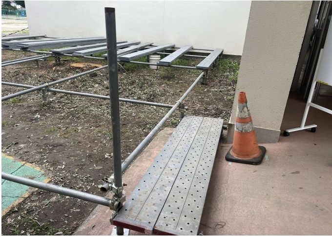
下地施工 通行部 段差高さ OK
