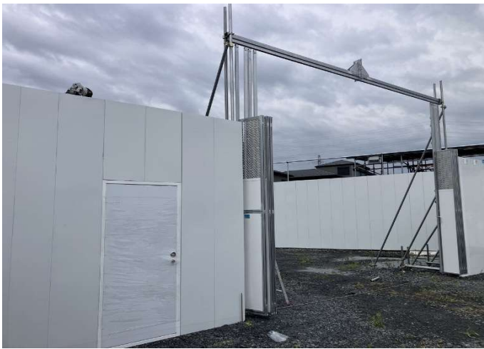
外観 通りゲート施工など OK
