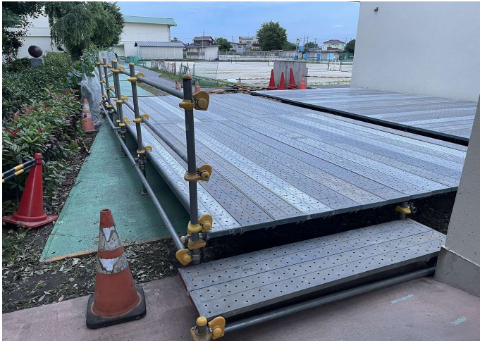
手摺部 養生 OK
