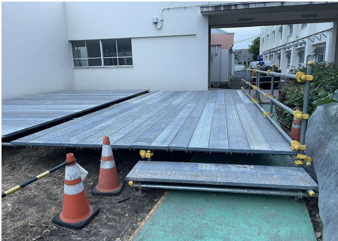
逆側 段差 補強 OK
