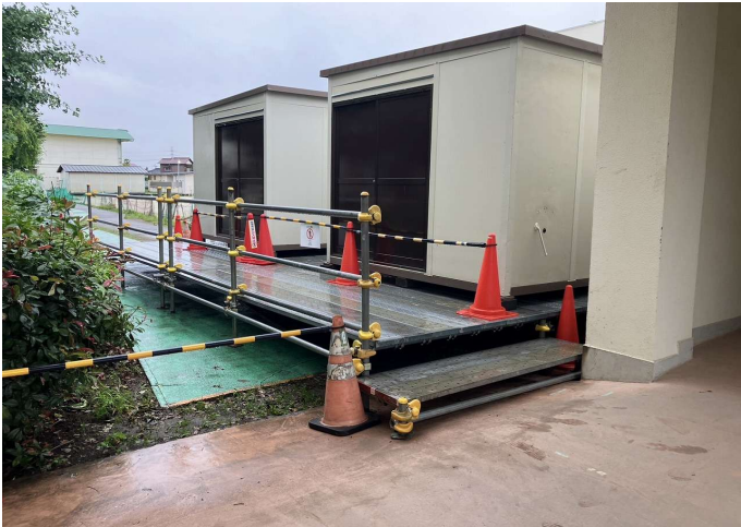
外観 通路補強 OK
