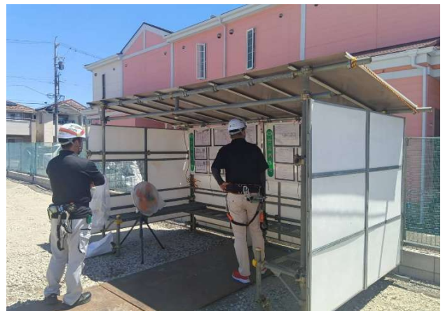
④ 休憩所施工良好
