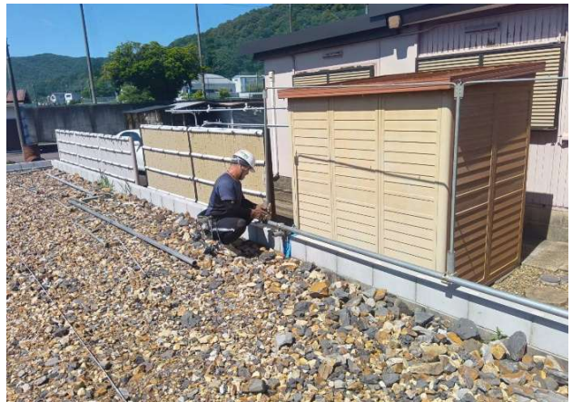
④ バリアネットフェンス施工中
