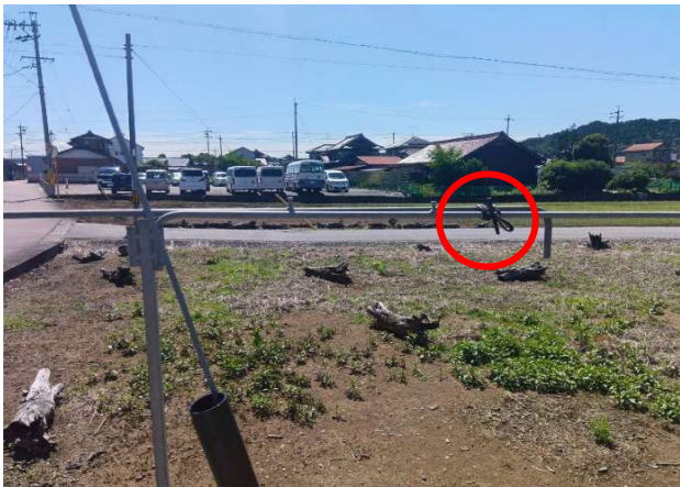
③ バーの重ね部分縛り付けOK
