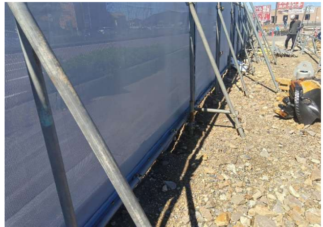
④ 太杭併用しての施工良好
