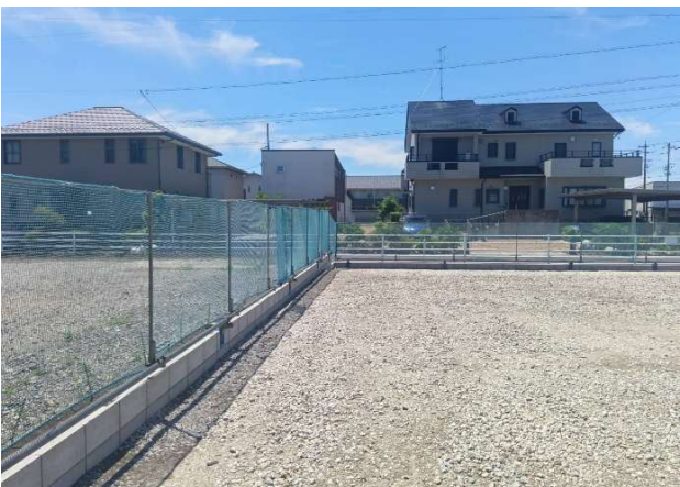
③ バリアネットフェンス施工良好
