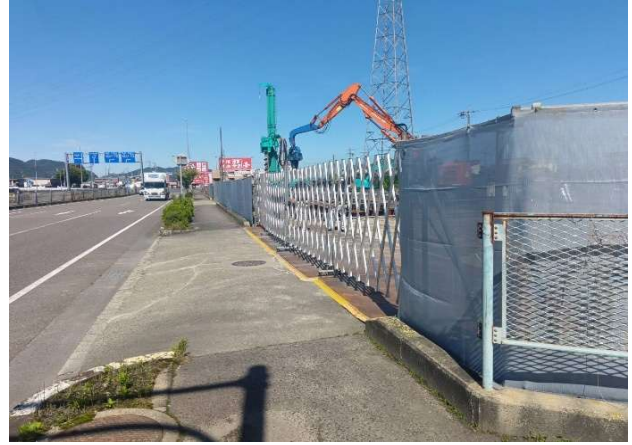
② ゲート面施工良好
