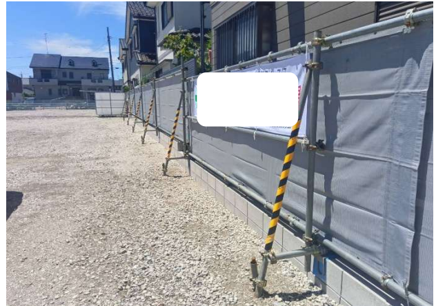
② シートフェンス施工状況
