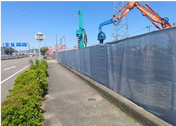
③ シートフェンス施工良好
