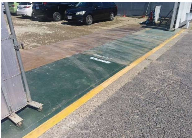
⑤ 養生鉄板敷設良好
