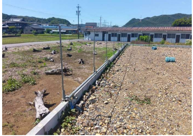
② 施工中バリアネットフェンス良好
