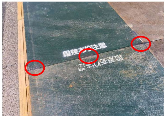
⑥ 鉄板溶接良好
