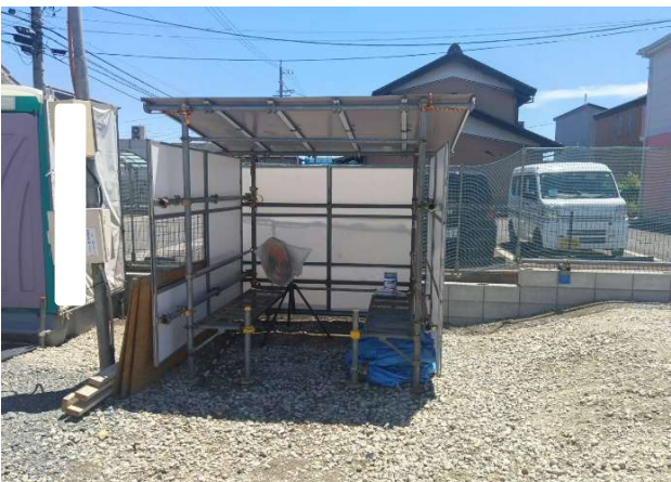
⑤ 休憩所施工良好
