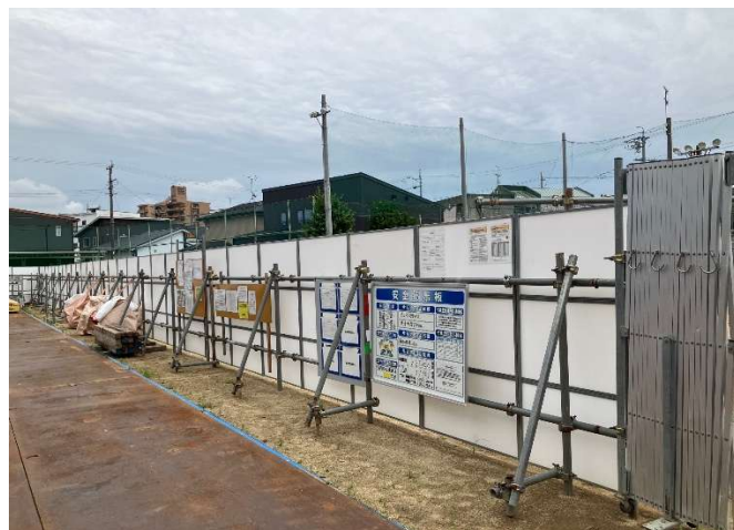
仮囲い骨組みOK
