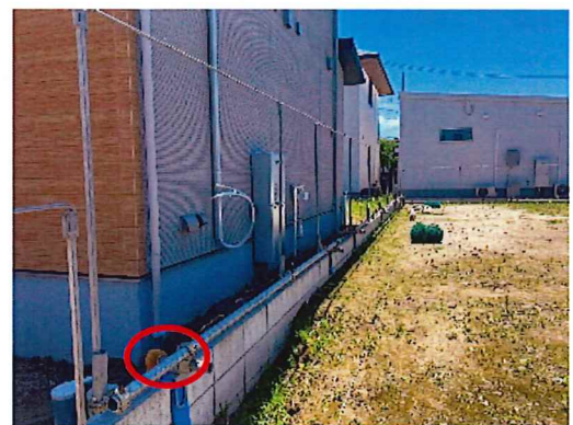
ネットフェンス問題ありませんでした 単管キャップにて隣地様への配慮もされていました
