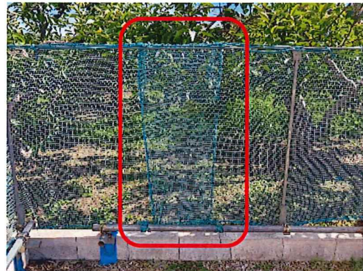
ネットフェンス重ね部 綺麗に施工されておりました
