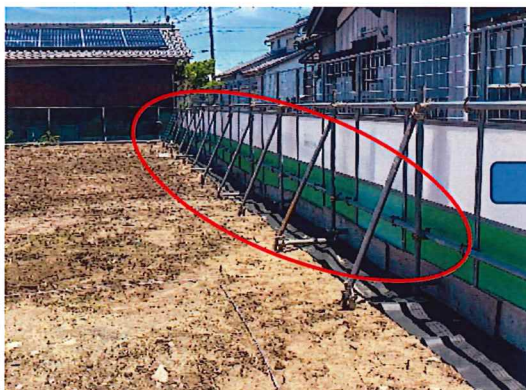
裏面 オリジナルフェンス状況 控えの角度等 奇麗に収めてありました
