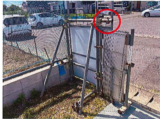
オリジナルフェンス裏側 ゲート部に養生材入るとよかった
