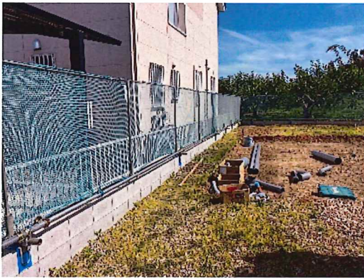
ネットフェンス状況
