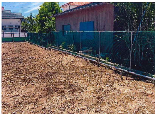
ネットフェンス状況 地盤が緩くポイント毎に太い杭施工 されていましたがもう少し太い杭あるとよかった
