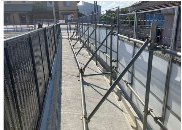
② コンクリート上への施工
