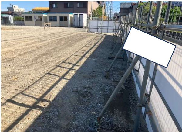
③ 通常通りの施工
