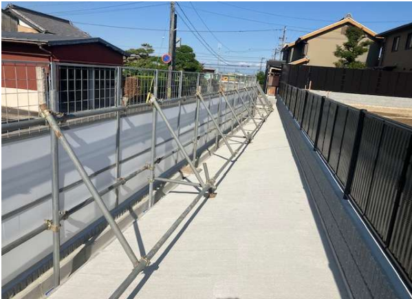
① コンクリート上への施工
