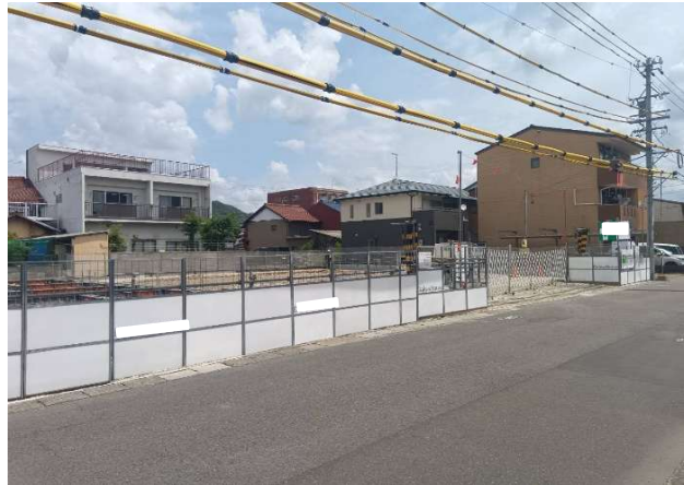
② 現場全景良好
