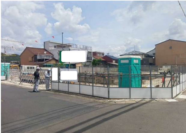
① 現場全景良好
