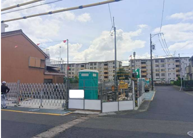
① 現場全景良好
