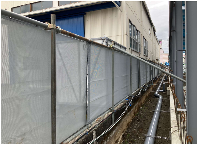
現場対応にて補強OK
