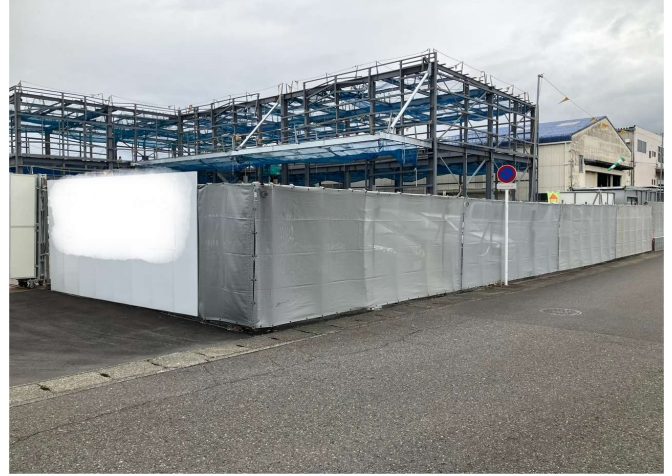
出角部 第三者配慮・補強OK
