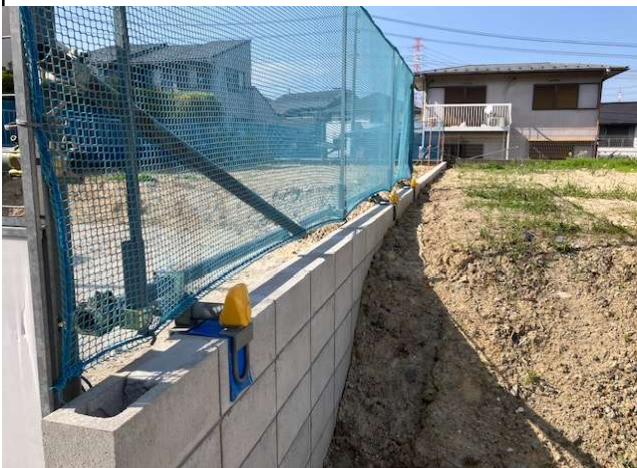
③ 隣地側、CBの養生OK
