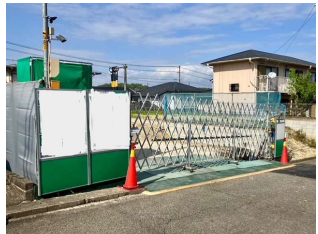
④ 鉄板段差の養生OK
