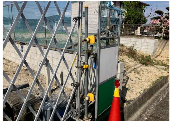
② 単管端部の養生OK
