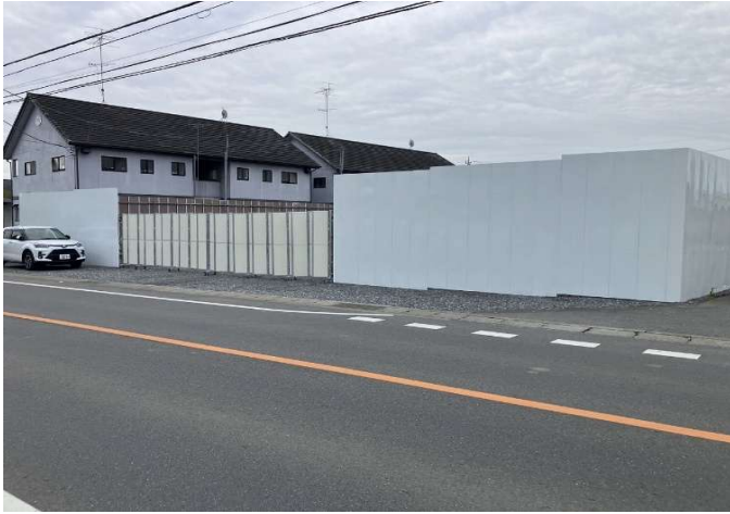
外観 通りなど 高低差処理 OK
