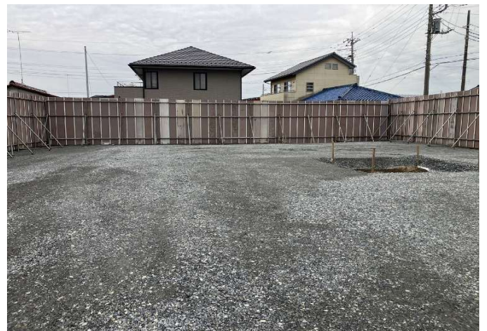
施工状況 OK
