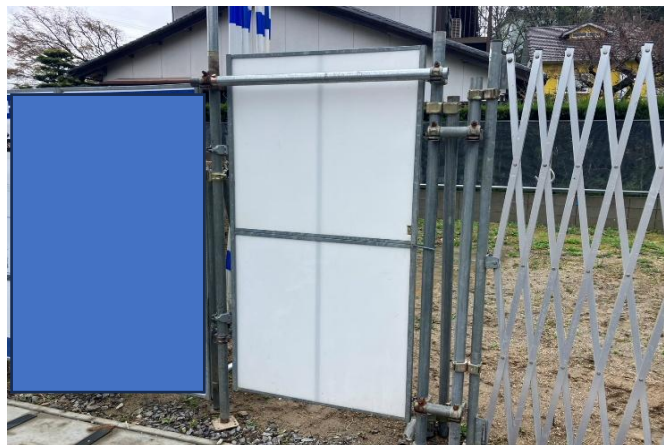
当社オリジナル扉施工状況
