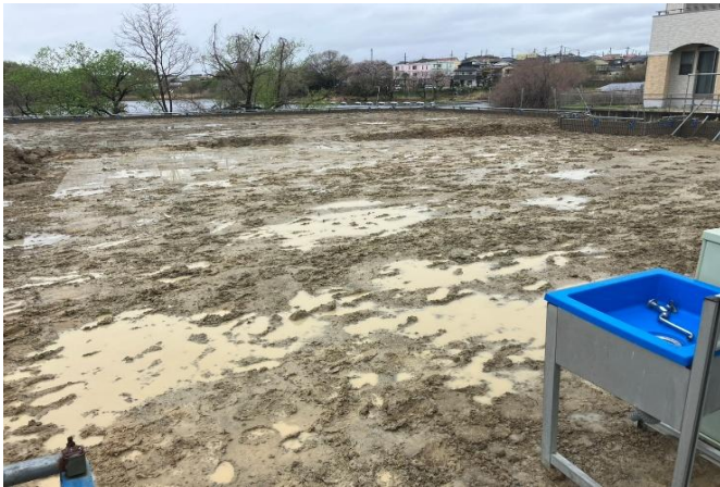
当日の現場状況
