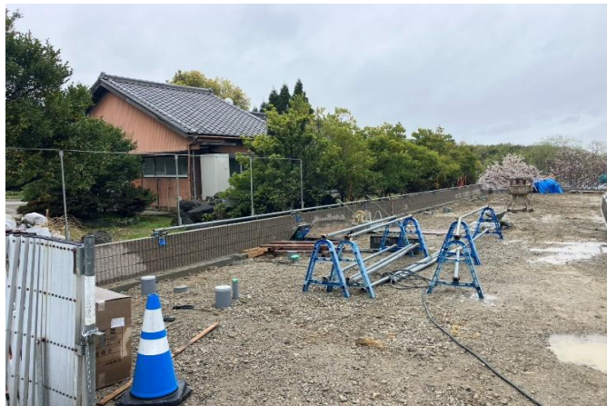
ネットフェンス骨組み状況
