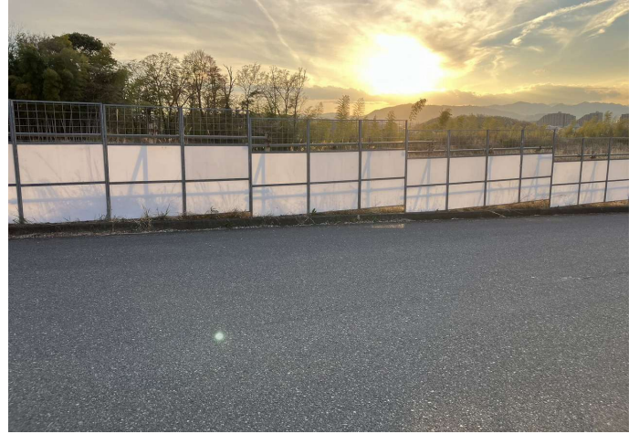
高低差 段差処理 OK
