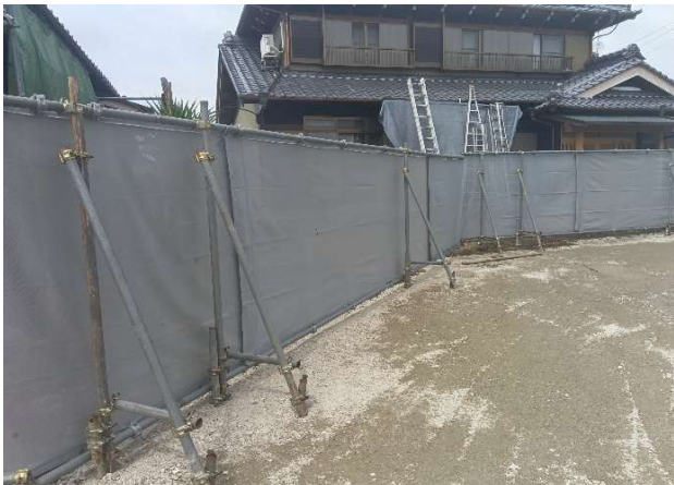
③ シートフェンス施工良好
