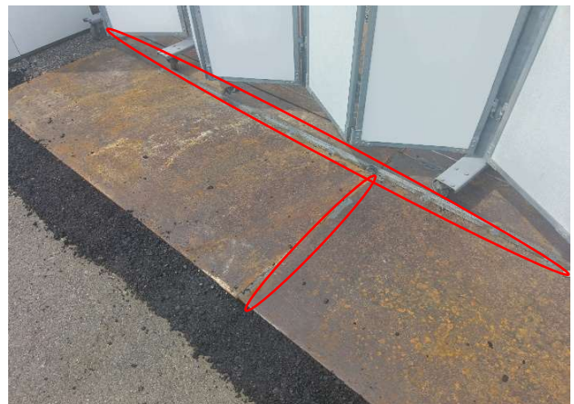
⑥ 鉄板及びガイドレールの溶接良好
