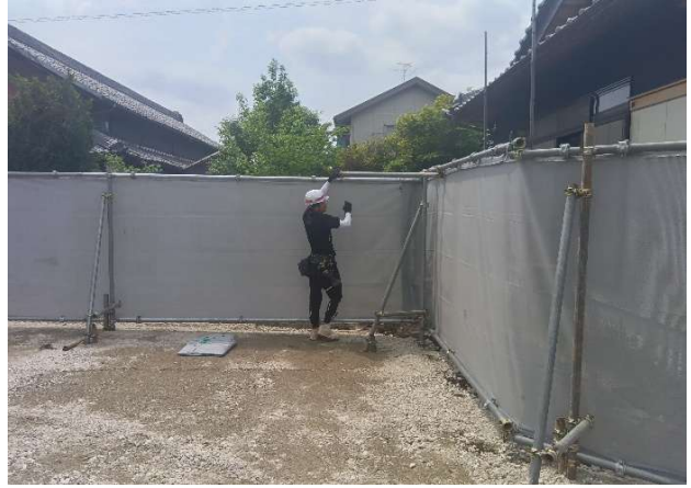
② シートフェンス施工中
