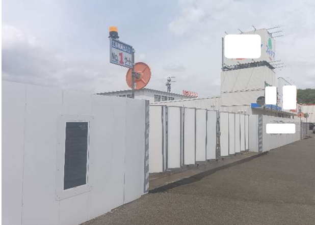
① 現場正面フェンス良好
