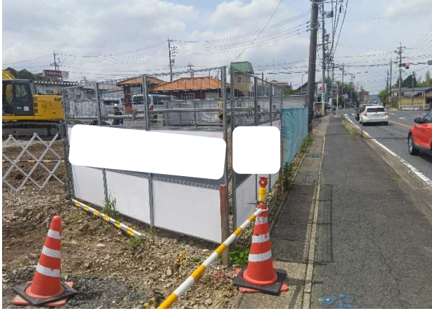
① 現場正面フェンス良好
