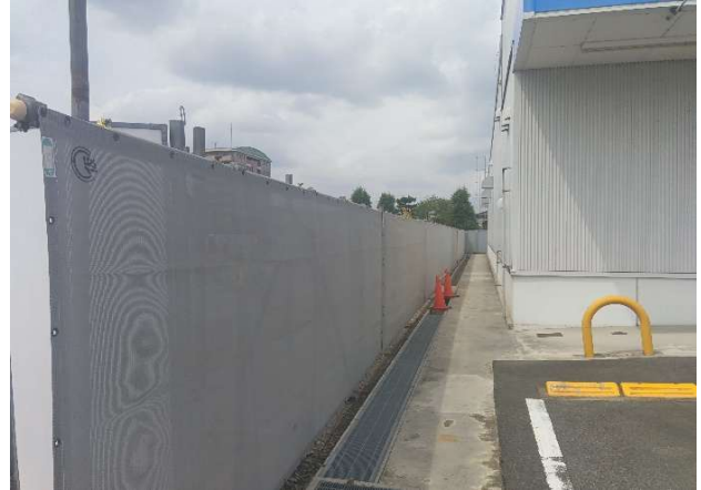
② シートフェンス施工良好
