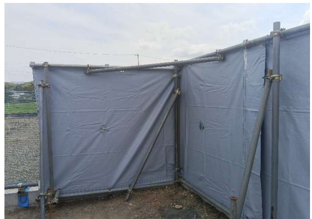
⑤ 防音シートフェンス施工良好
