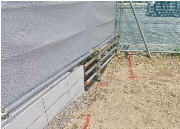
③ CBが無い部分の侵入防止措置良好
