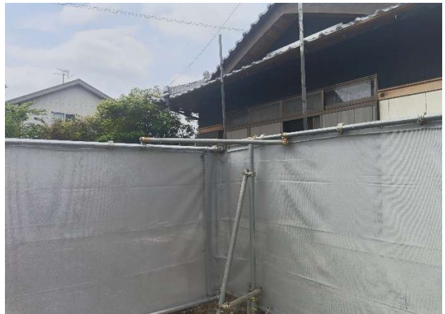
④ 火打ちの取り付けOK
