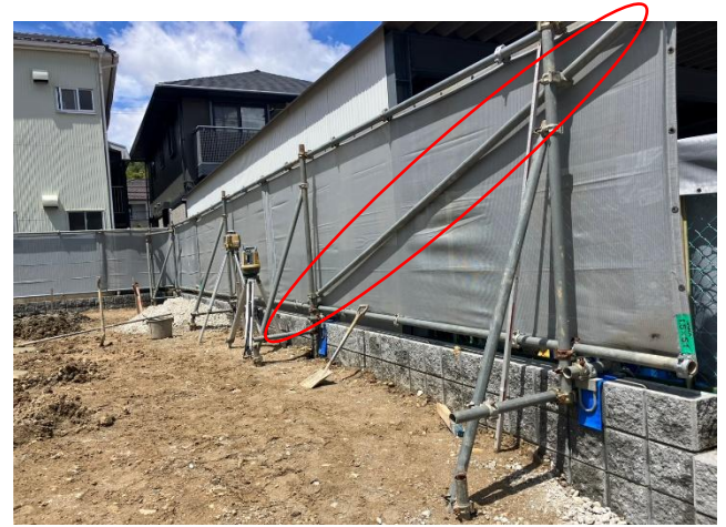
側面 シートフェンス状況 ゆがみ防止の配慮されていてよかった
