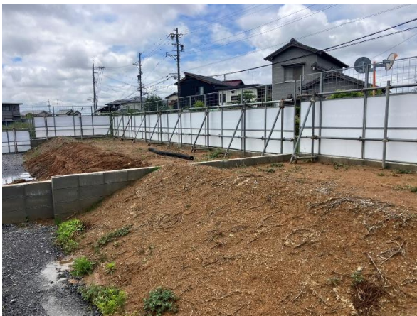
パネルフェンス骨組み状況① 問題ありませんでした
