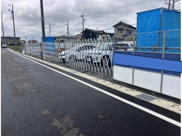
現場正面状況 鉄板のご提案できていたらよかった ロゴ入りフェンスに色あせあり 買い替え手配していきます
