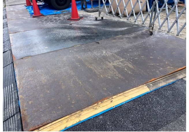
乗り入れ鉄板状況 しっかり養生されておりました
