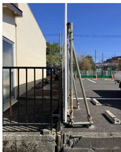
建て起こし・通り
