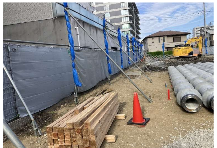
杭養生 シートまとめなど OK
