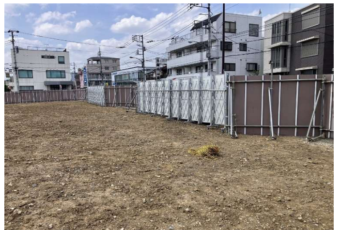
隅切りゲートなど 補強 OK
