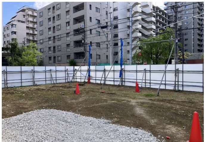
コーナー部 杭養生施工 OK
