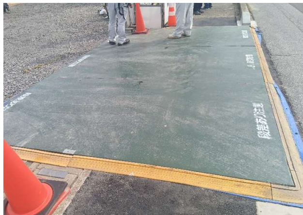
⑥ 養生鉄板敷設良好
