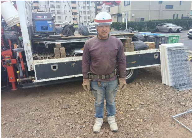
① 現場正面パネルフェンス良好
