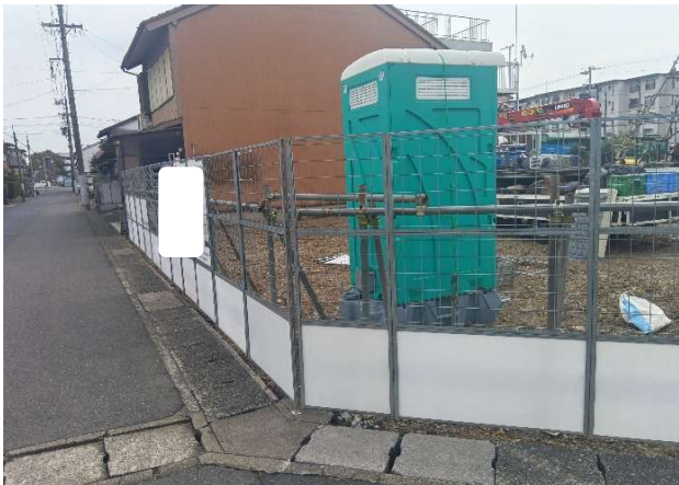
③ 道路面フェンス施工良好
