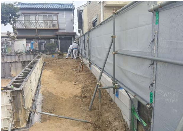
③ シートフェンス施工良好
