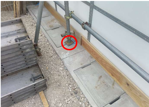
③ フェンス下巾木の設置良好 建地ベースの養生良好
