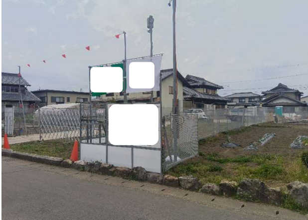
① 現場全景良好
