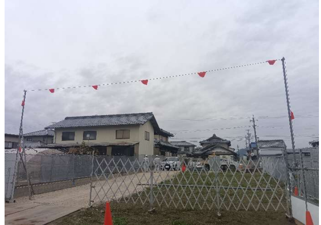
② 高さ表示トラロープの設置OK
