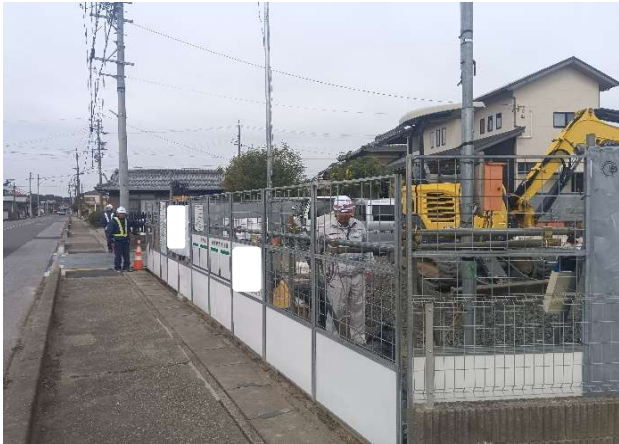
① 現場全景良好
