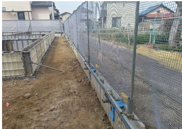
④ バリアネットフェンス施工良好
