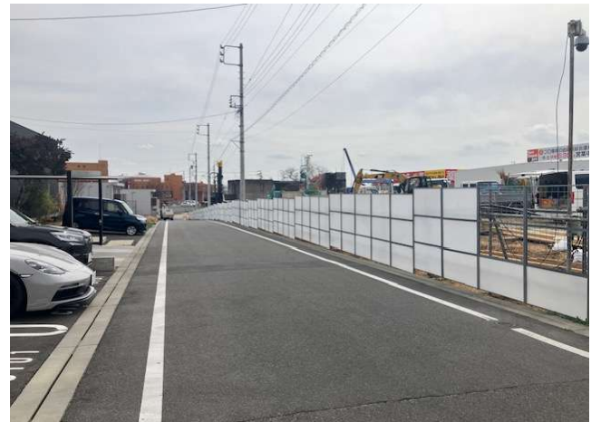
④ 勾配に合わせた施工良好
