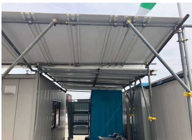
⑤ 休憩所屋根勾配工夫あり
