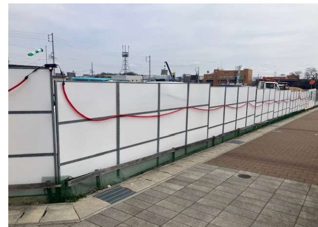
⑥ 正面チューブライト施工
