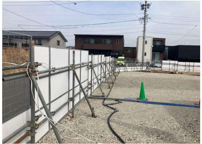
② 仮囲い裏側骨組み良好
