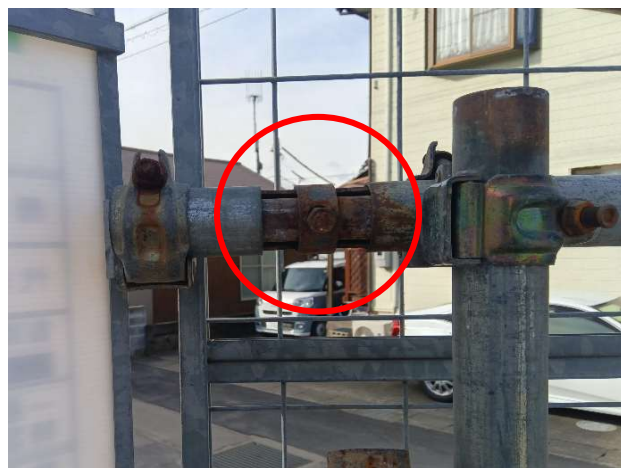
③ ジョイント部分の差し込みが浅い箇所があったので注意
