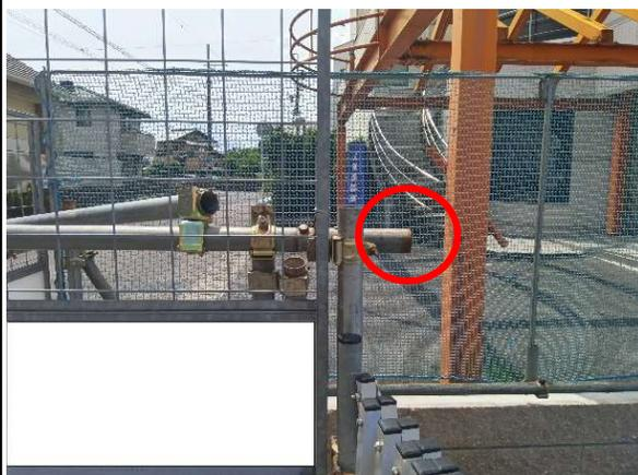
施工後の現場では不要な単管の突き出しが散見されました。単管の突き出しは気付かず怪我の原因にもなる為、極力突き出さない様に部材を選定、やむを得ず突き出した場合は端部の保護をしっかり行う様に指導しました。
