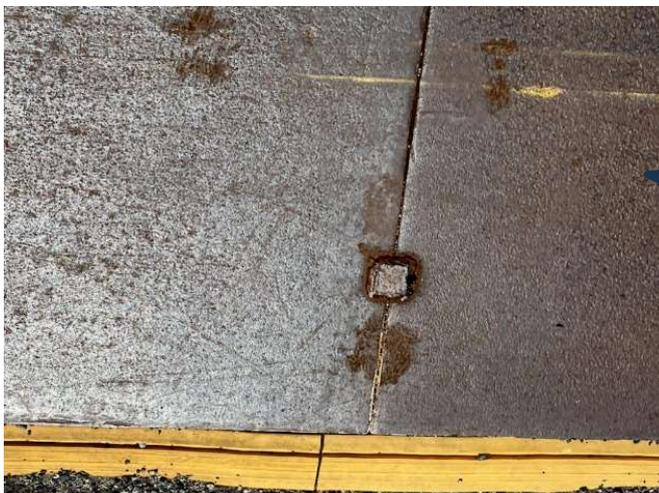
鉄板を溶接した写真となります。鉄板を隙間、段差がなくなるよう敷設してから溶接しており、良い施工でした。
