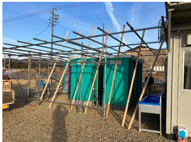
特設トイレ囲い状況 細かいところまで 計算された施工 ヨシ！！
