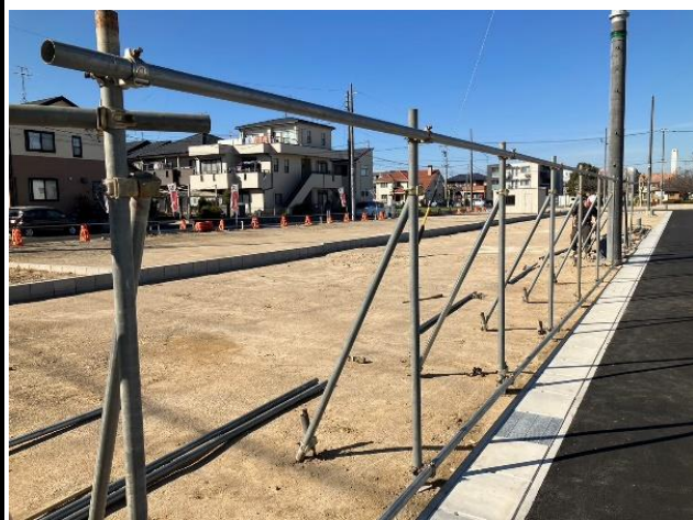
施工中状況 ハンマーの振り方等 安全作業 ヨシ！！
