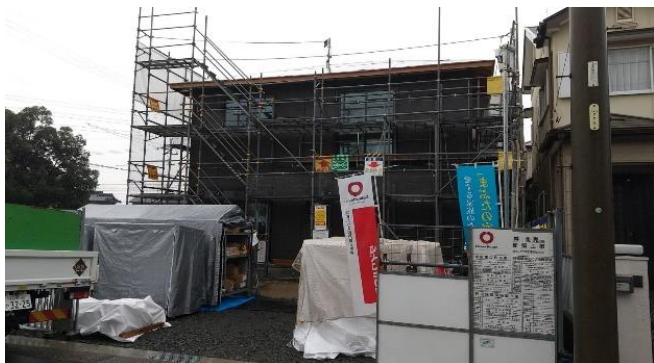
先行足場全景
