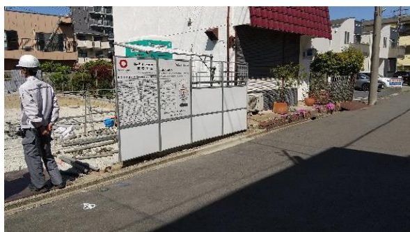
現場正面施工状況
