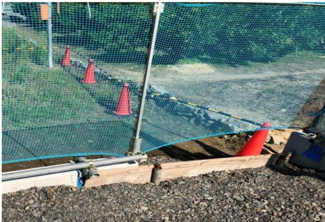
擁壁の無い場所にバリアネットが施工されてますが、安全を考え土留めを設置しています。隙間がある場所は危険が潜んでいます。安全を第一に考えた施工を続けて参ります。
